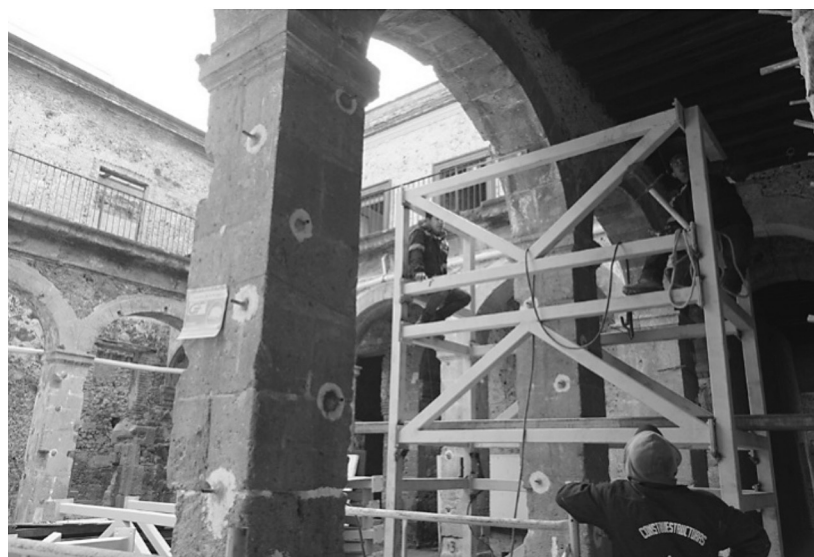
Restauración de arquerías Fotografía: Archivo personal
