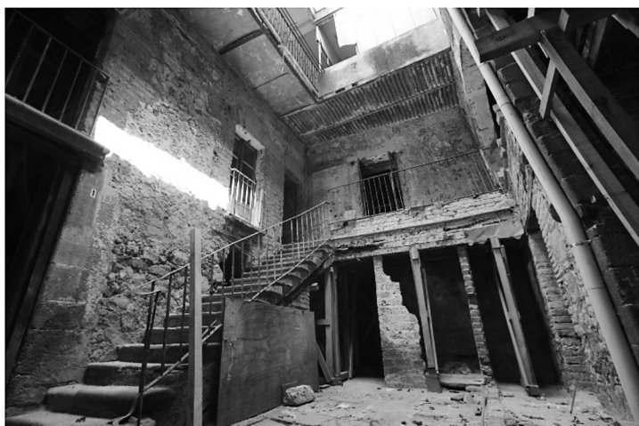
Patio interior antes de la intervención Fotografía: Archivo personal
