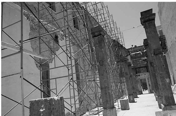
Trabajos de intervención en las Cárceles de la Perpetua Fotografía: Archivo personal
